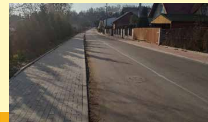
Remont drogi gminnej ul. Oświecenia w miejscowości Rząska
