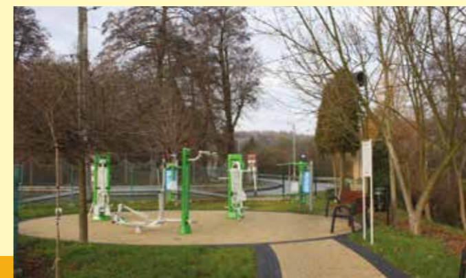
Budowa siłowni zewnętrznej w Balicach
